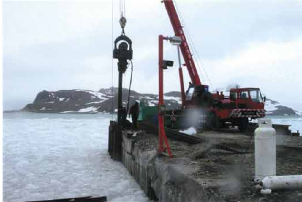
◀ 부두 보수 공사
