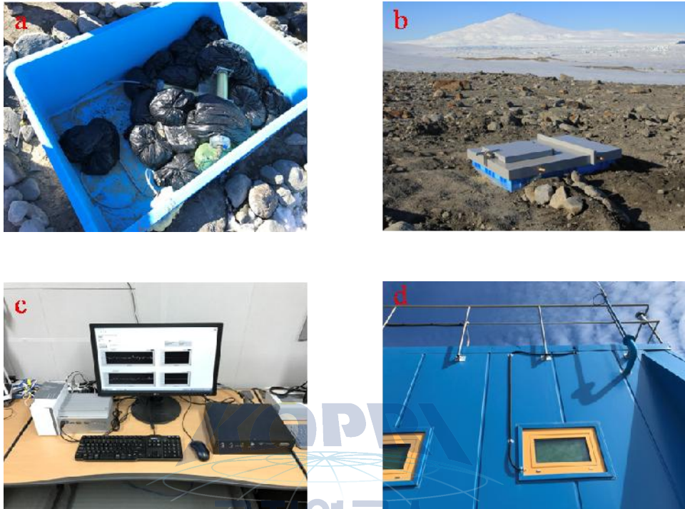
그림 49. 서치코일 자력계의 설치 완료된 모습
