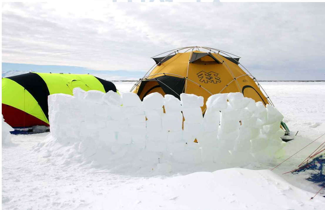
그림 3-4-8. 메인건물 눈 벽 설치
