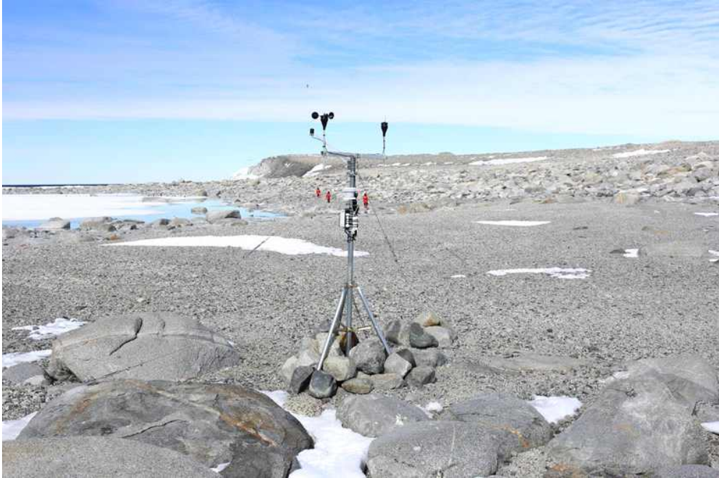
그림 3-5-10. 자동기상측정장치(AWS, Inexpressible Island)
