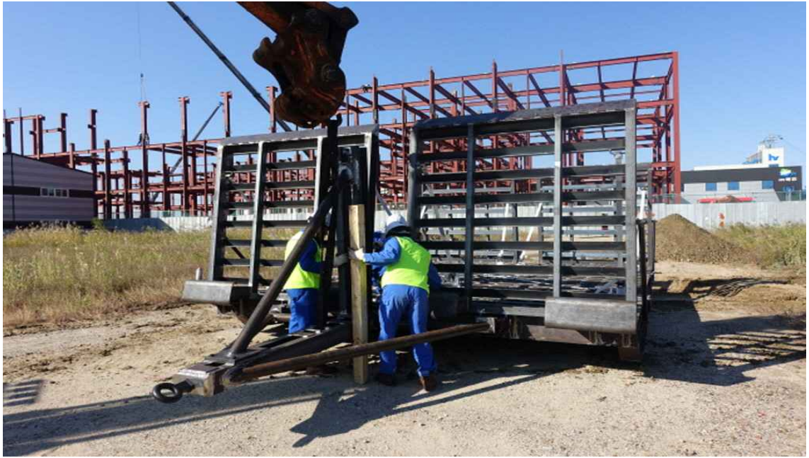
가설교량 설치를 위한 견인장치 설치
