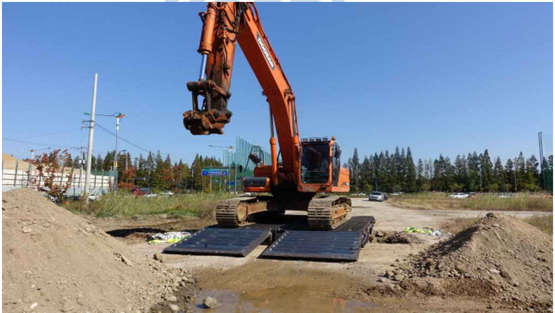
크레마스 위 교량 설치 완료 후 2회 왕복 시운전 완료
