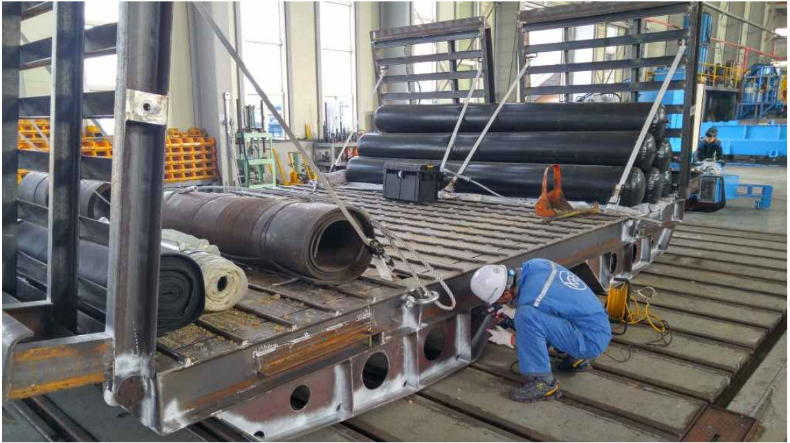
시운전 완료 후 가설교량 비파괴 검사 (MAIN 모듈 하부)
