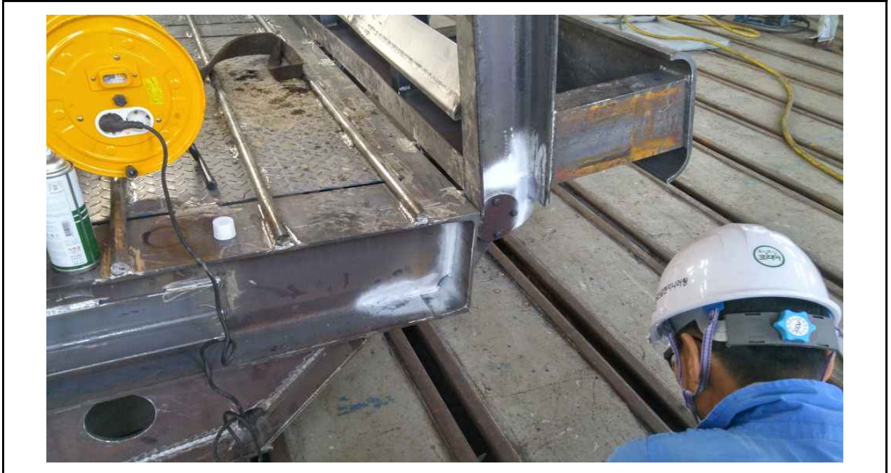
시운전 완료 후 가설교량 비파괴 검사 (RAMP 모듈 연결부)
