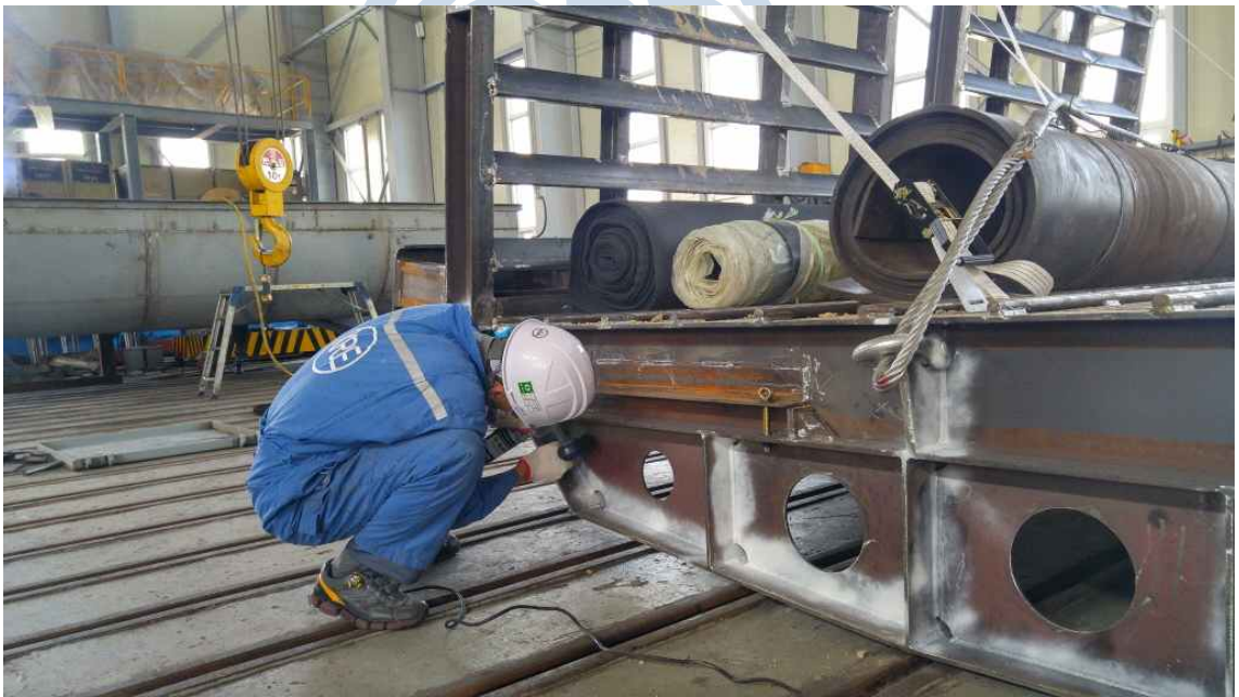
가설교량 비파괴 검사 및 보강 완료 (MAIN 모듈 하부)
