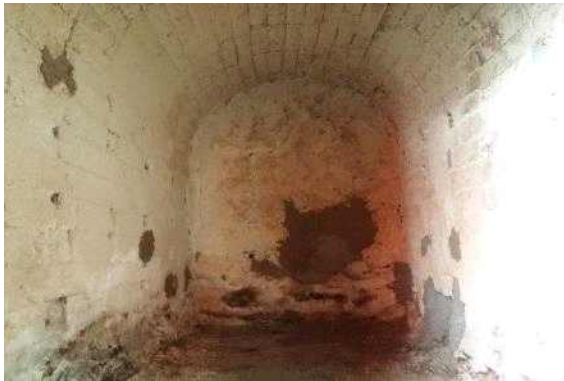
<소각기 내부 보수 후>
