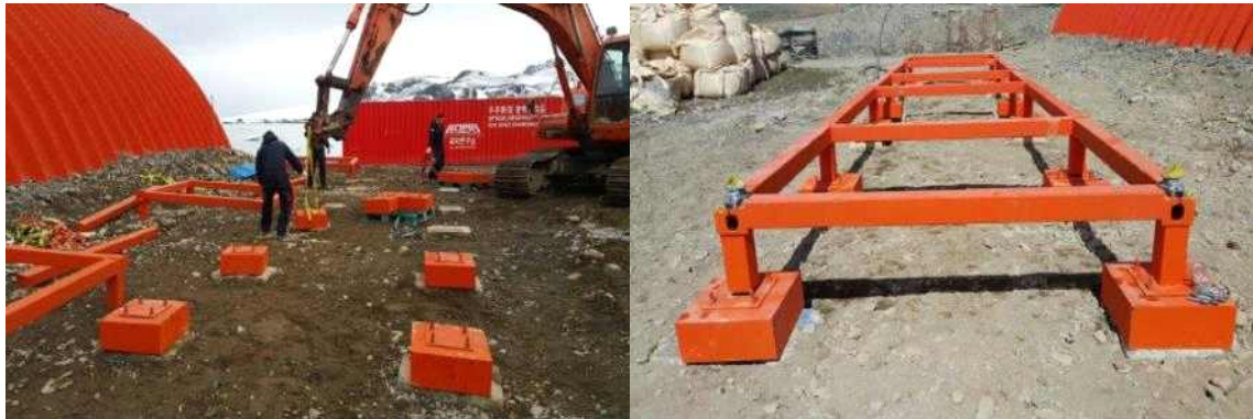
<기초 PC블럭 설치>
