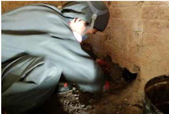
<소각기 내부 보수 중>
