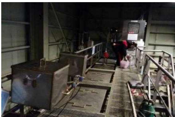
<종균제 주입탱크 설치>
