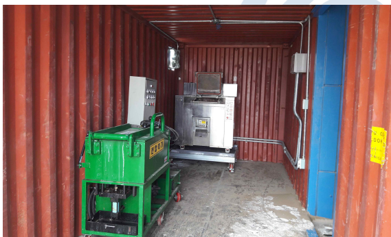
<탈각기 및 캔압축기 이동설치 후>
