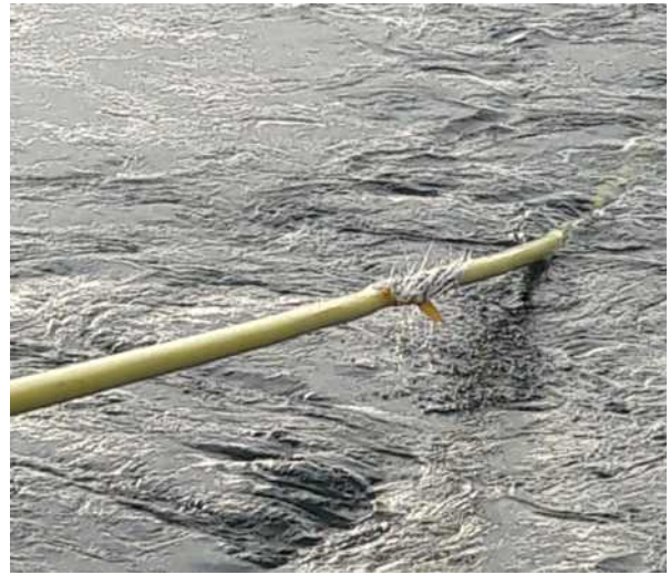
<파손된 벨 하우스 케이블 사진 (1)>
