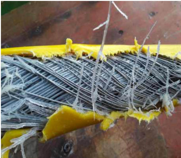
<파손된 벨 하우스 케이블 사진 (2)>
