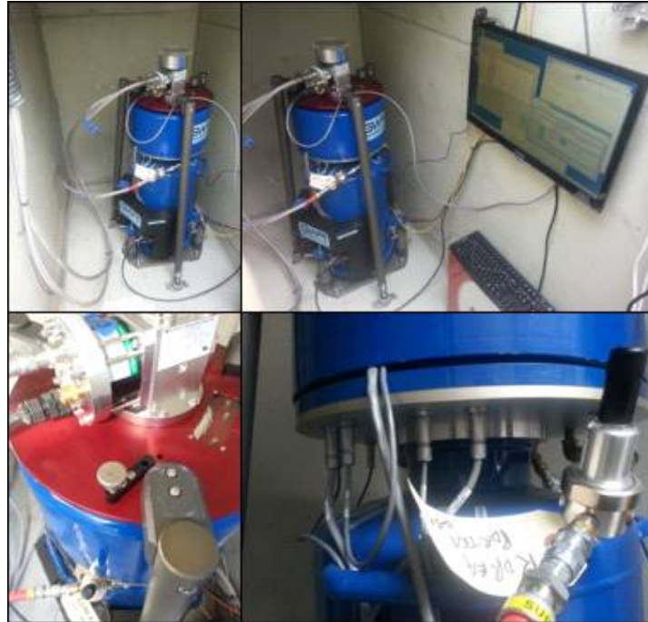
그림 114 중력 센서부 및 냉각기 설치
