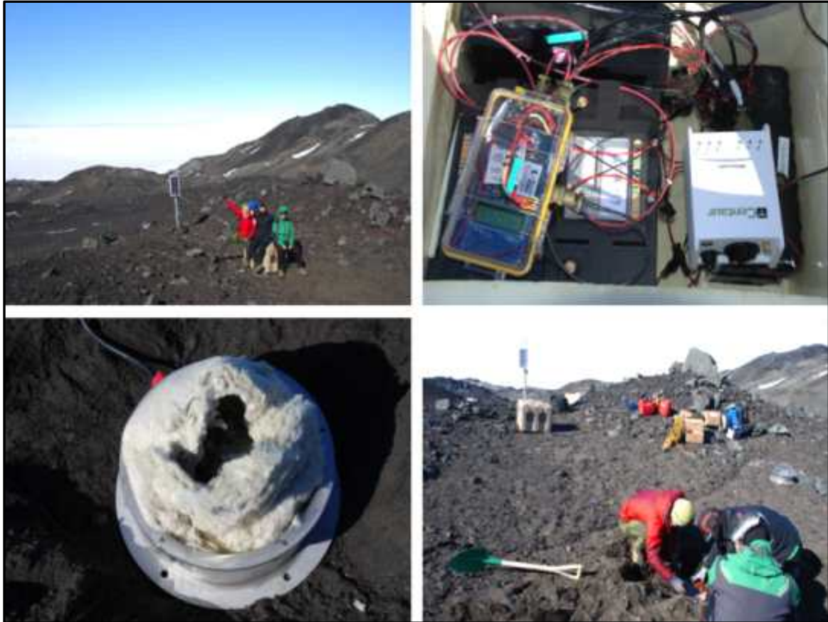
그림 93 신규 설치된 멜번 화산 관측망 KP07 관측소 전경.
