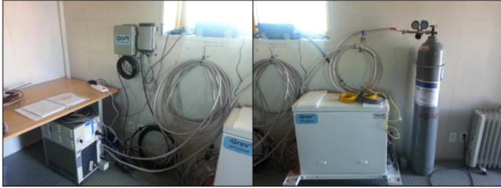
그림 572 지구물리관측동 내 압축기 및 전원공급장치
