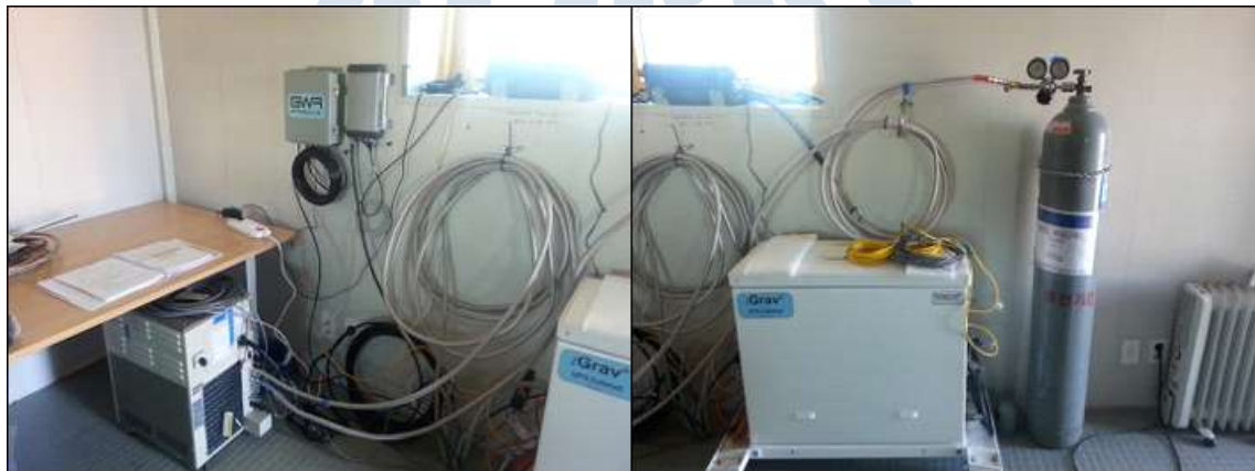
그림 115 지구물리 관측동 내 압축기 및 전원공급장치 설치
