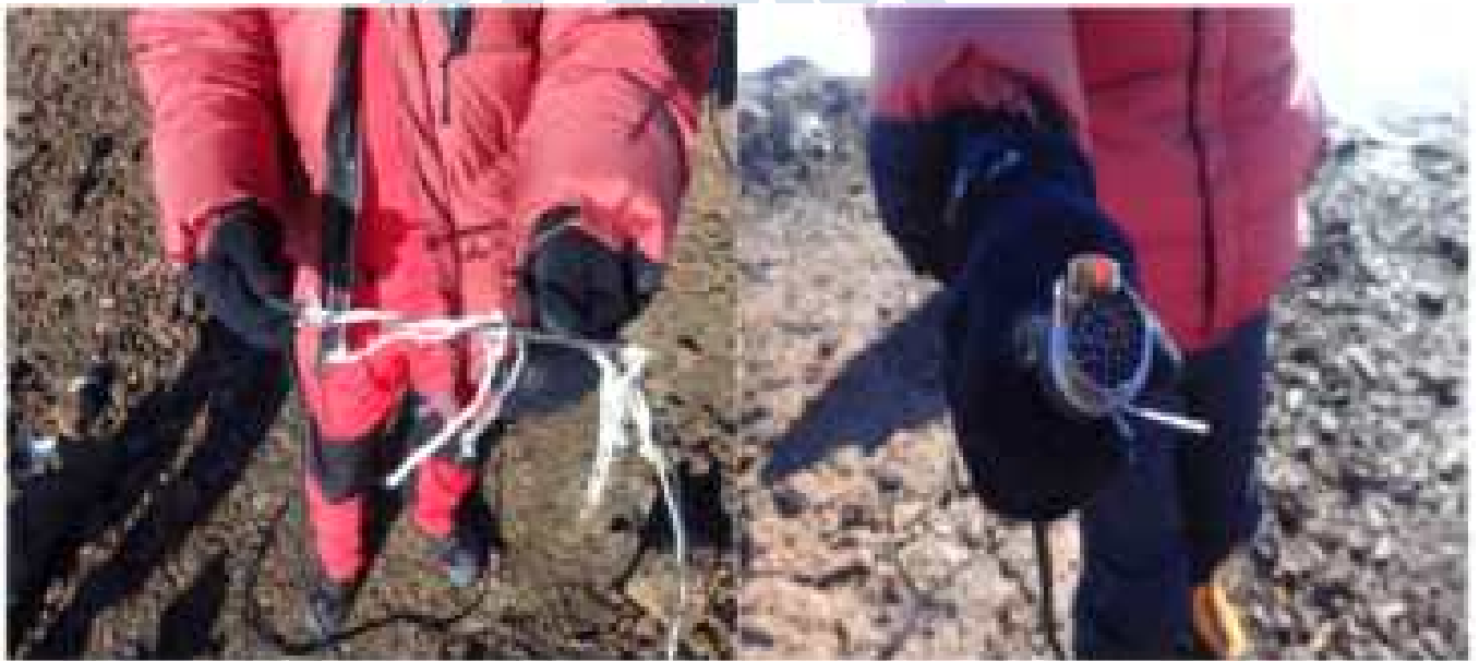
그림 171 동계 기간 동안 강한 바람으로 인해 기록계 단열박스가 유실되고 케이블이 파손된 KDG06 관측소
