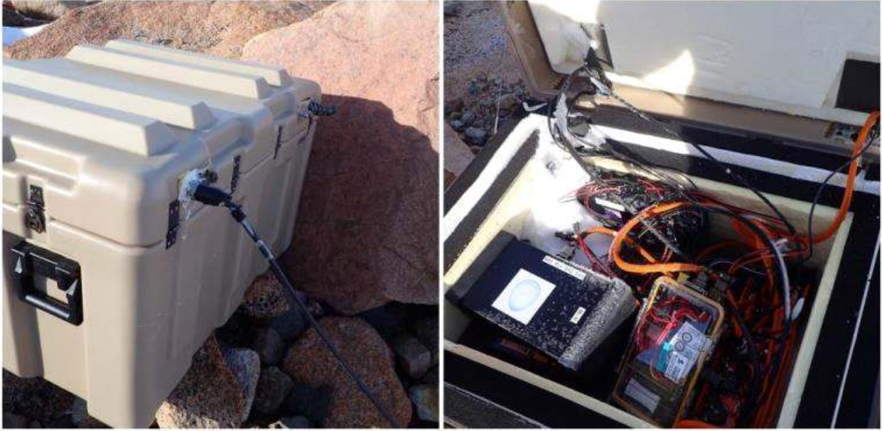
그림 125 강풍으로 케이블 및 단열박스가 파손된 KDG07 관측소
