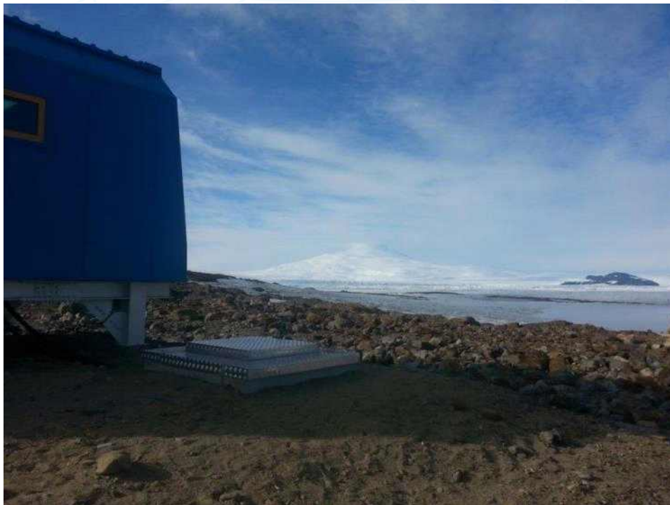
그림 111 지하에 매설된 중력계실 전경
