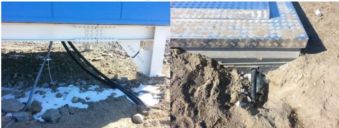
그림 113 냉각기-압축기 간 헬륨 호스 및 각종 케이블용 관로 매설
