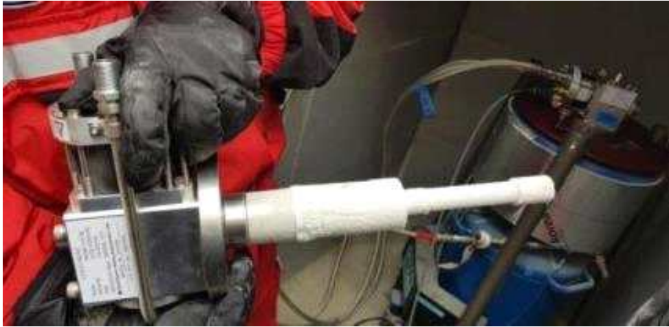
그림 184 장보고기지에 설치된 초전도 중력계 cold head 교체
