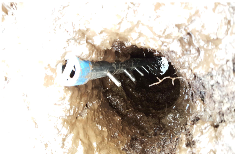
그림 25 온도계 설치 결과
