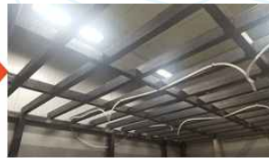
복층 골조 설치
