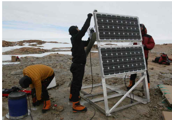
<그림 15> 남극 지진관측을 위한 장비 전력공급을 위한 태양광 설치
