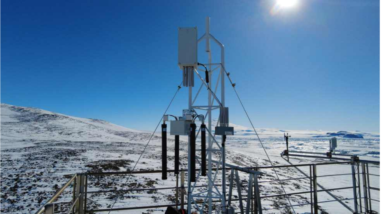
[사진1] 장보고기지 인근 11층 높이의 워크업 타워에 설치된 IoT 통신장비
