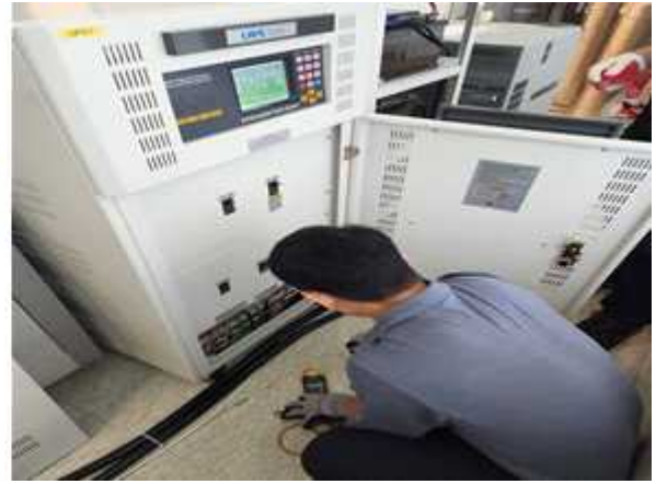
<그림 337. 무정전 전원공급장치 배터리 교체(좌) 및 전압 측정(우)>
