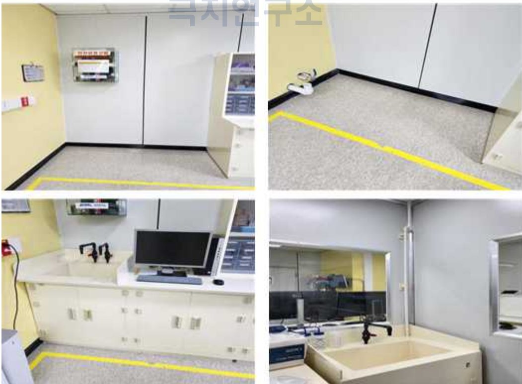
<수도 설비 증설 후>
