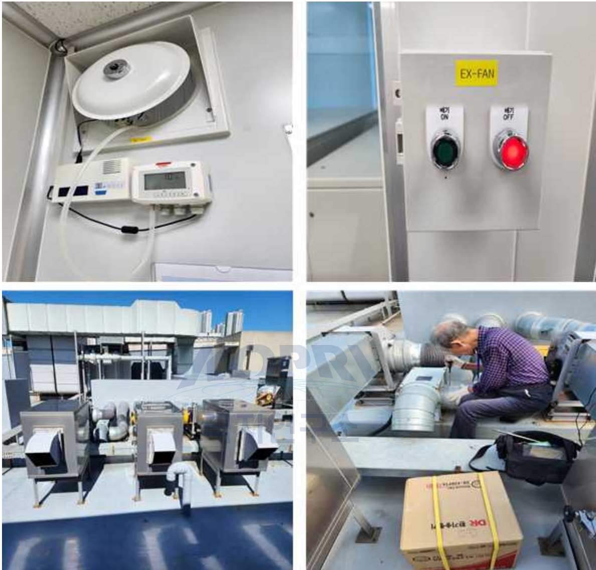
<그림 339. 청정실험실 공조시설 이상 확인 및 배기팬 교체>
