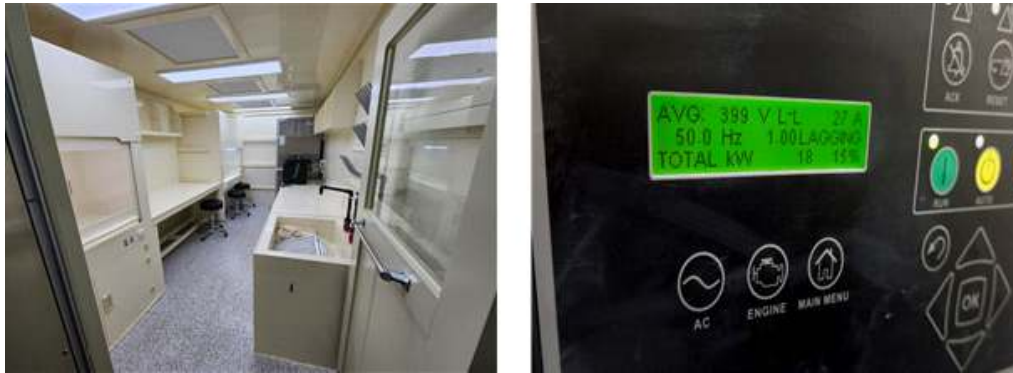
<그림 262. 이동식 청정실험실 가동 후 발전기 부하량 확인>
