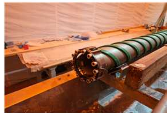
<시추공 하부 금속물질 제거 작업>
