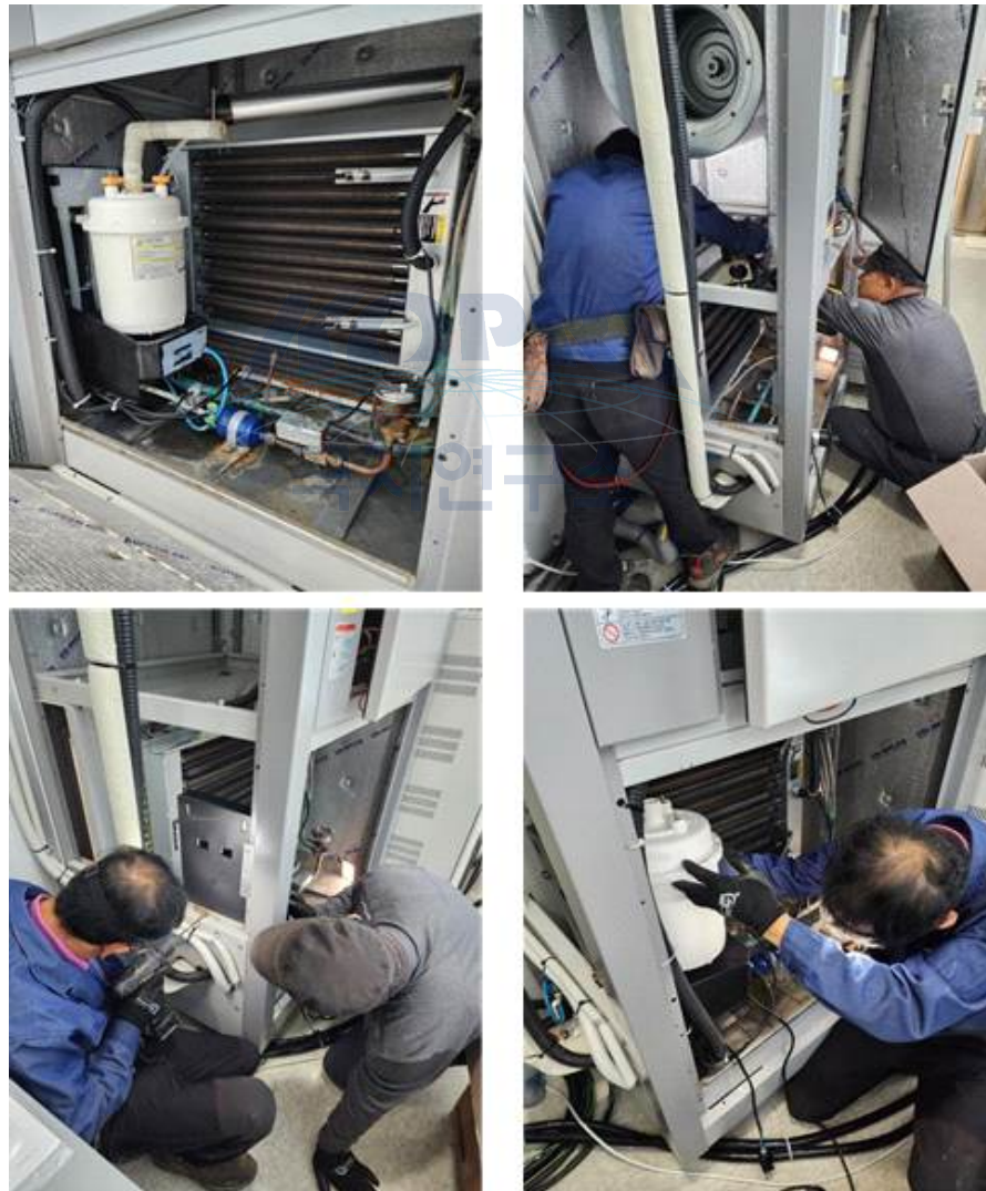
<그림 321. 향온향습기 가습모듈 유지보수 작업>
