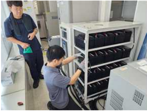
<그림 337. 무정전 전원공급장치 배터리 교체(좌) 및 전압 측정(우)>
