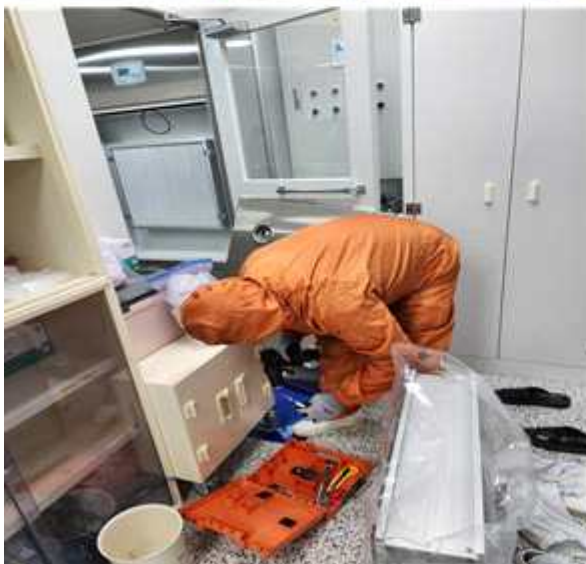
<그림 338. 청정실험실 내 공기정화 필터유닛 교체 및 상태 점검>
