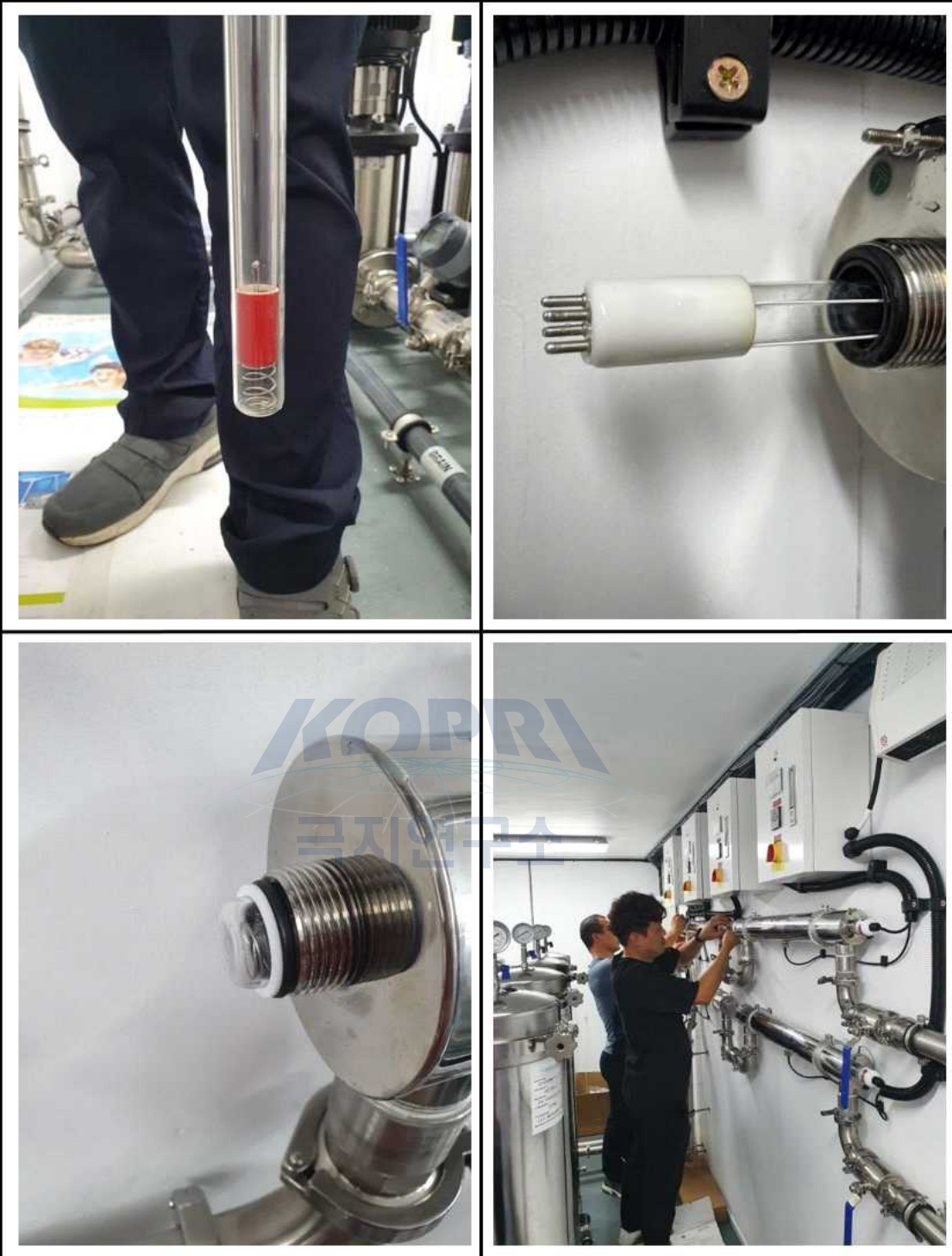
그림 152 멸균시스템 내부의 UV 램프 설치 및 정상 작동여부 확인
