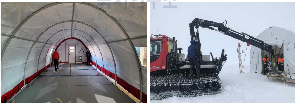
그림 249 Weatherhaven S4 프레임 아치 텐트 내부 및 중장비 활용 설치
