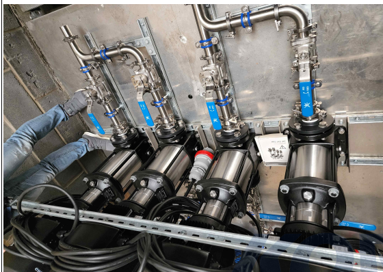
그림 231 가열 루프 순환펌프 - Grundfos 사의 CR 15-5 AFAE-HQQE 모델사양
