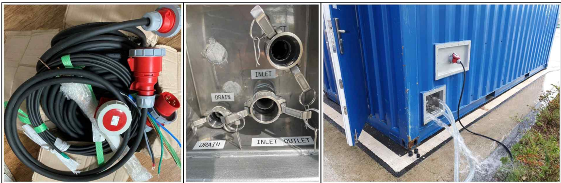
그림 150 전원공급장치 및 호스 제작
