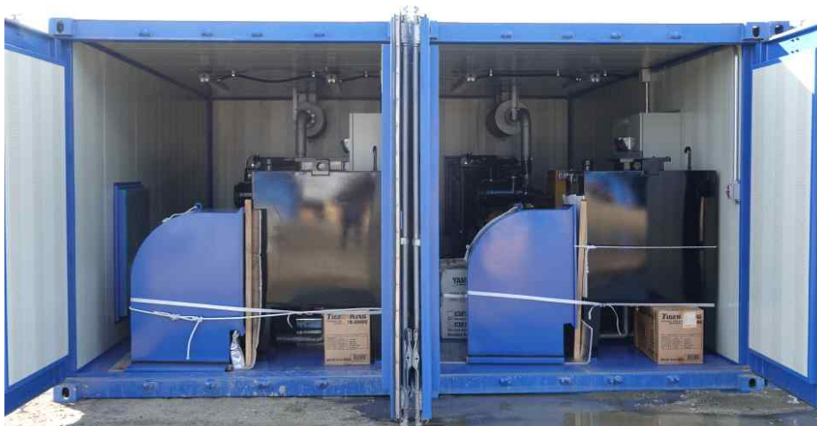
그림 266 개발 완료된 100kw급 모듈형 시추동력 발전기 2기
