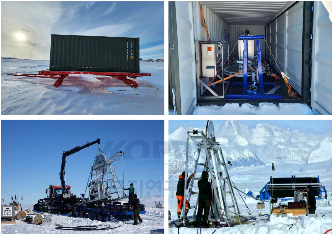
그림 254 캡스ตัน&시추타워 및 컨트롤패널 설치 및 가동 시험
