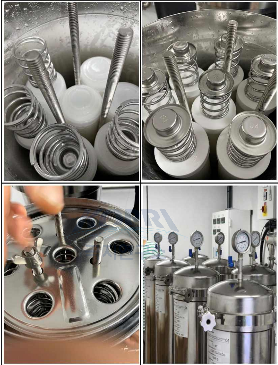
그림 153 4단계 필터 카트리지 장착 및 정상여부 확인
