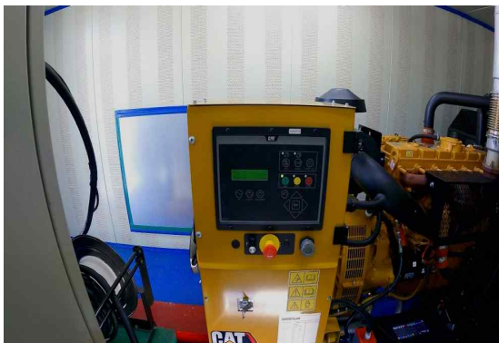
그림 251 100kW 발전 컨테이너 가동 시험
