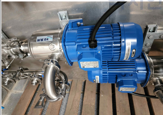
그림 232 가열 루프 순환펌프 - Grundfos 사의 CR 15-5 AFAE-HQQE 모델사양
