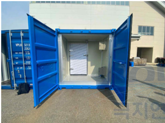
[천문우주환경 관측모듈 격문 및 관측실 밀폐 모습]
