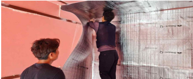
[천문우주환경 관측모듈 단열 및 구조보강 제작 모습]
