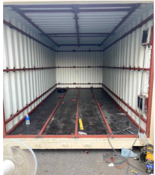
[천문우주환경 관측모듈 단열 및 구조보강 제작 모습]
