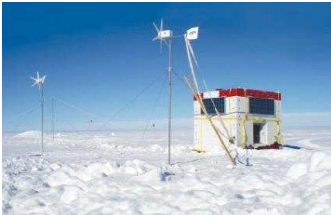
<남극내륙에 설치된 무인 자동화 지구물리 관측소>
