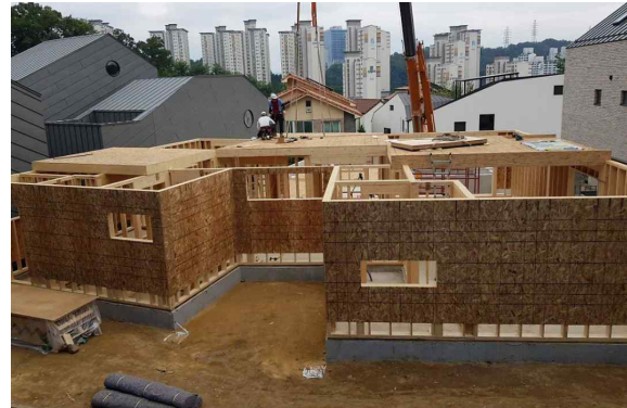
<모듈러 주택 시공 현장>
