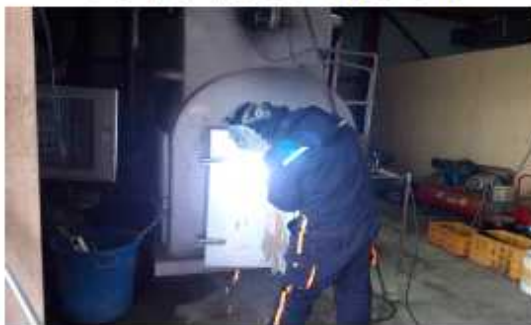
소각로 정비 및 보수
