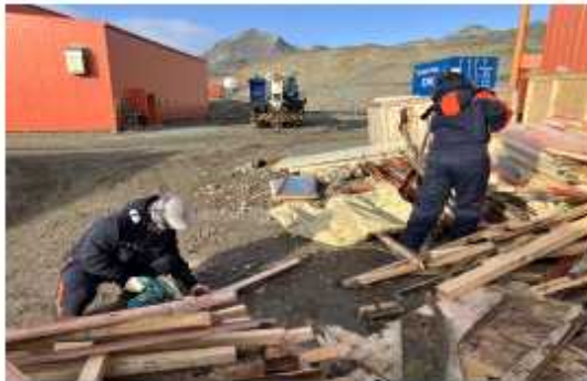
구명복 탈의실 철거 폐기물 정리
