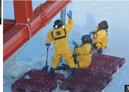
1 동파된 이중관을 점검하는 월동대원들. 2 설상차 트랙 조립 중인 월동대원들. 3 취수구 주변의 얼음을 깨는 월동대원들.
