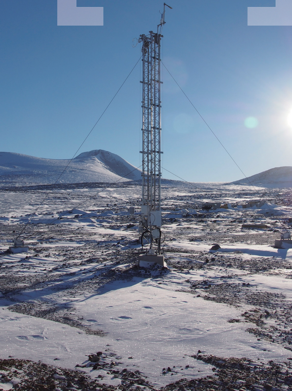
기상관측 및 대기과학 연구를 위해 설치된 10m 타워.
