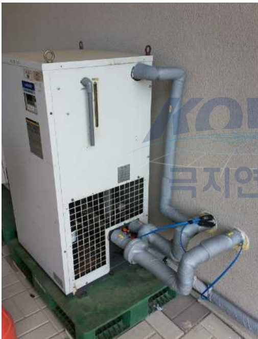
그림 3.2.12 냉각장치의 급배수 모습
