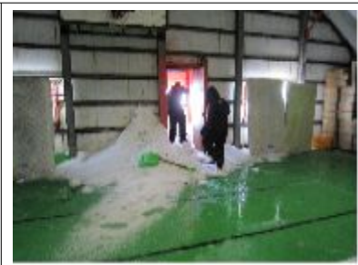
c. 강풍 및 블리자드 발생 시 시설노후화에 따른 눈·비 유입 현상
