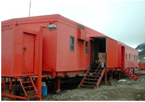
a. 지질지구물리연구동 전경
