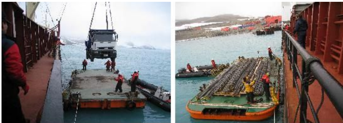
그림 1-20. 남극세종과학기지 하역작업 전경 (대수선 당시)
