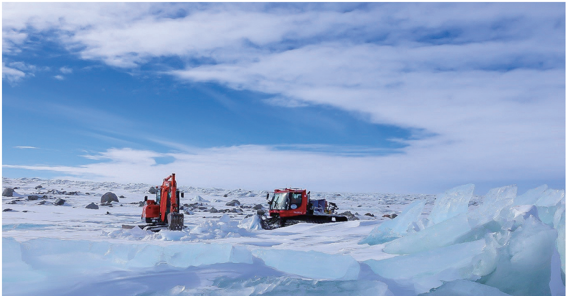
그림 7 크레바스를 통과 후 타른 플랫 지역에서 평탄화 작업 중인 굴삭기와 설상차.
